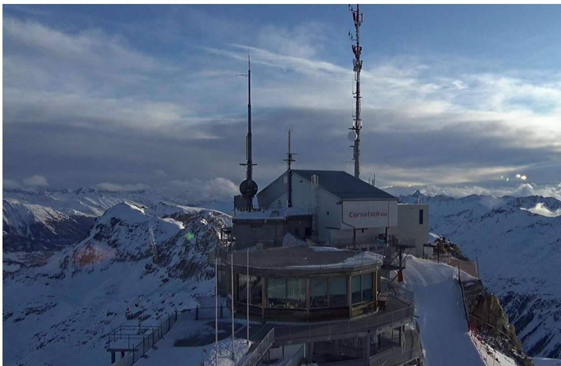
Figura 3 – Piz Corvatsch, la sensoristica della stazione è posizionata sui due tralicci di sinistra e sul terrazzo (foto da https://www.corvatsch-diavolezza.ch/ , non datata).
