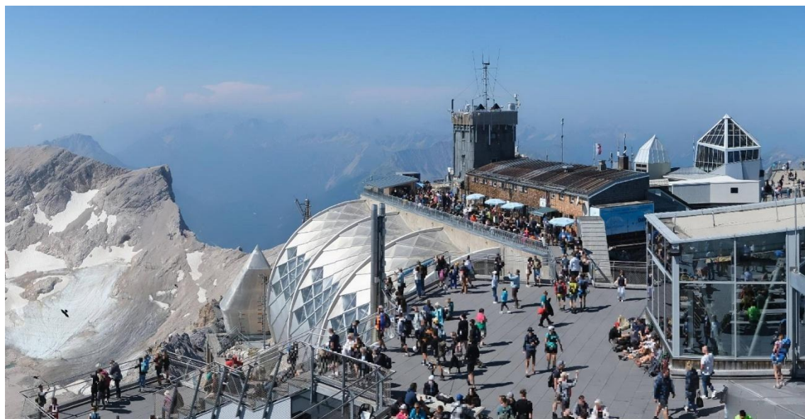
Figura 6 – Il complesso turistico dello Zugspitze, in una calda giornata estiva. In fondo all’edificio, la parte vecchia con la torretta e il terrazzo meteorologico (foto da https://zugspitze.panomax.com , immagine del 24/08/2024, ore 12:00 CEST).
