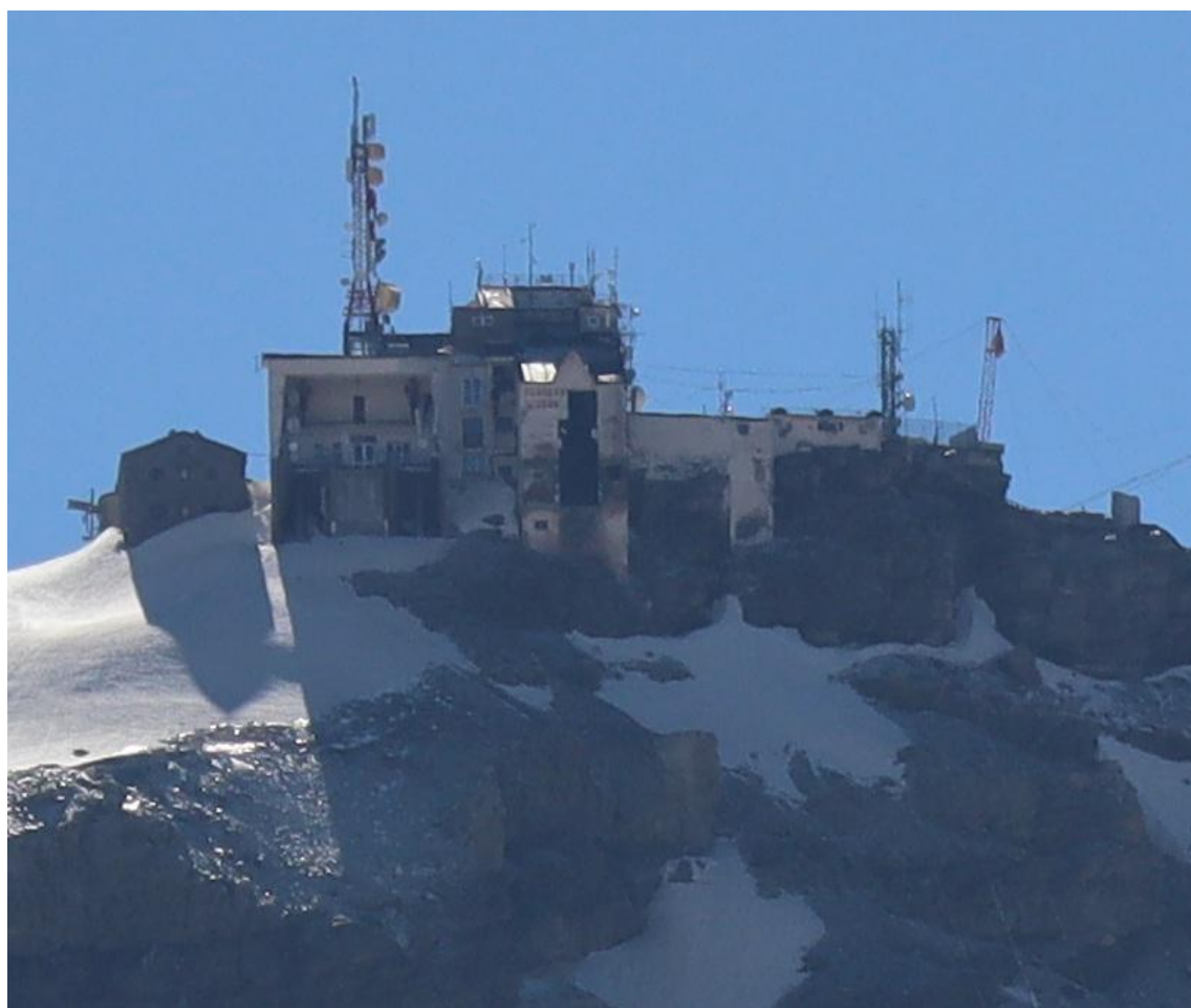
Figura 3 – Lo sperone roccioso di Testa Grigia e l'arrivo della funivia al Plateau Rosà. Sul terrazzo alla destra del traliccio più alto sono installati i sensori meteorologici di Pian Rosa (foto G. Nigrelli, 04/07/2024).
